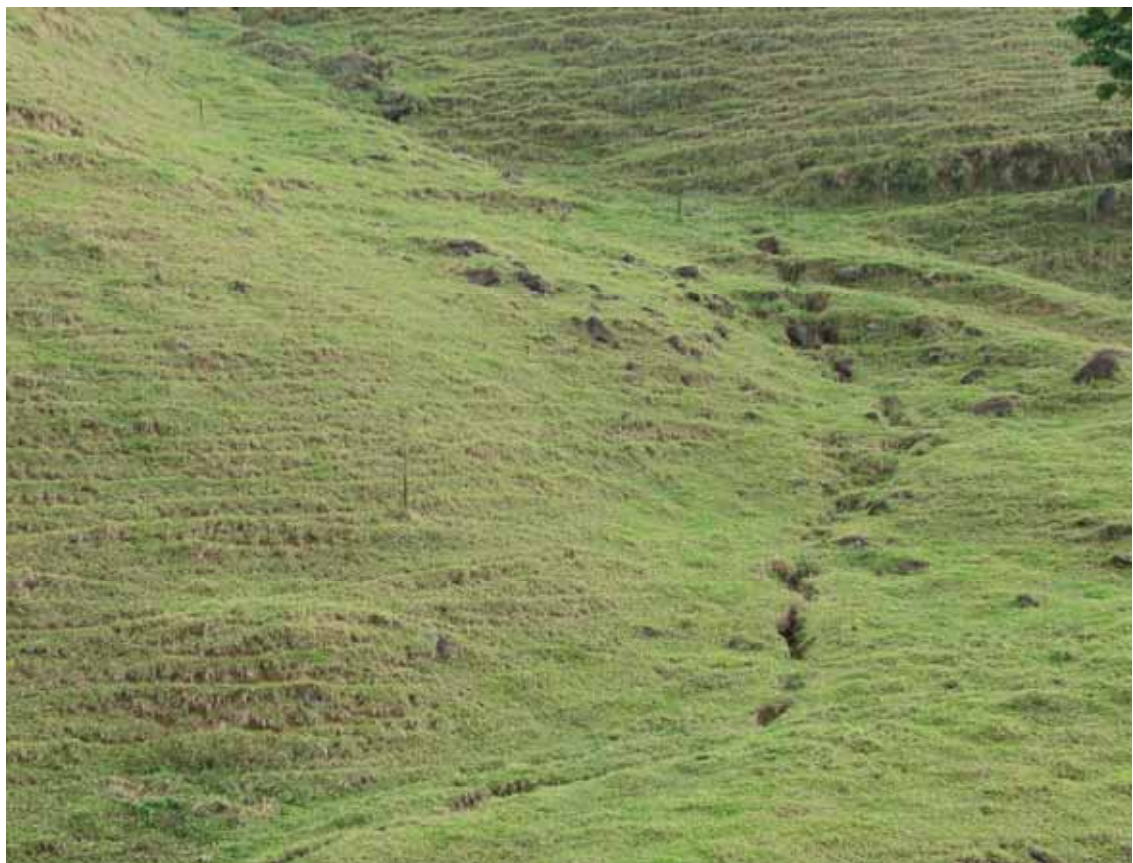
Foto 16 - Ravina associada ao creep . Fotografada no Compartimento Jaqueçaba. Ao seu redor é possível identificar matações expostas indicando a retirada de cobertura pedológica por erosão laminar.
