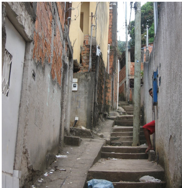
Fotografia 4: poste no meio do beco, dificultando a passagem e possíveis reformas para melhoria da escadaria no Alto Bairro da Penha.
