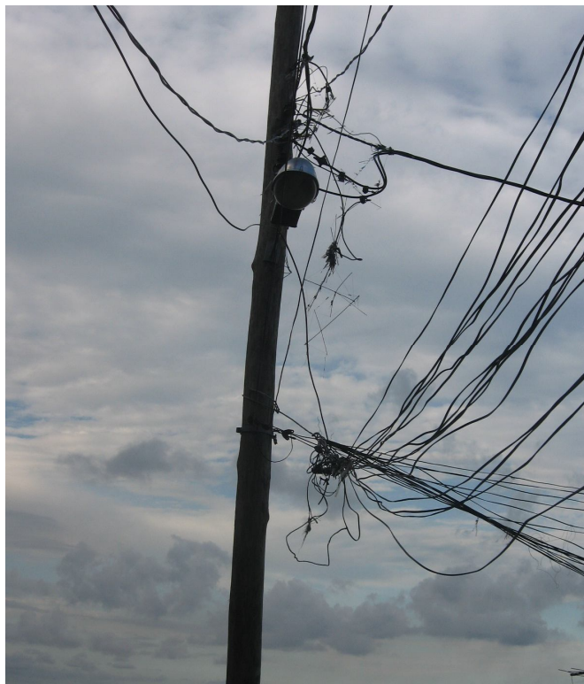
Fotografia 6: Emaranhado de fios extremamente mal esticados no Alto Bairro da Penha.
