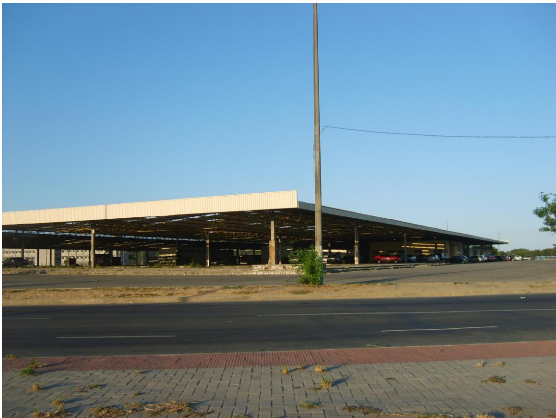
Figura 2 – Vista parcial do antigo Shopping do Povo , 2007 Fonte: Foto do autor
