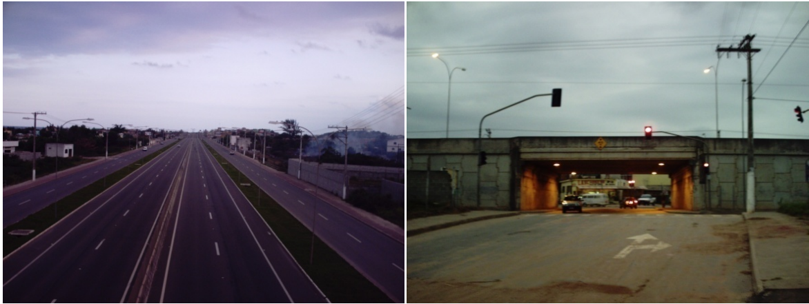
Fotografia 4 – Rodovia do Sol e passagem do viaduto do Bairro 23 de Maio. Data: 02/07/2007.
