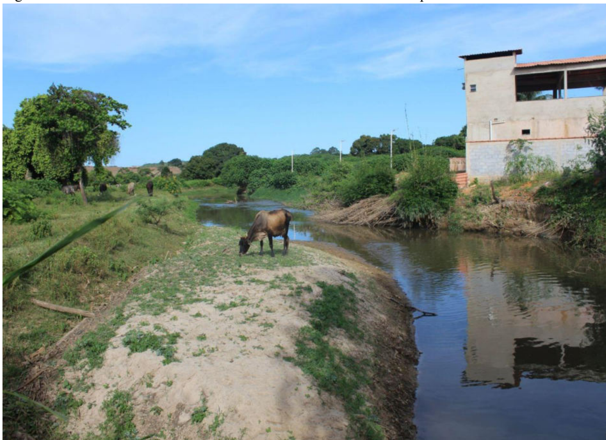
Figura 27 — Residência com risco de desabamento na curva do rio no ponto 10
