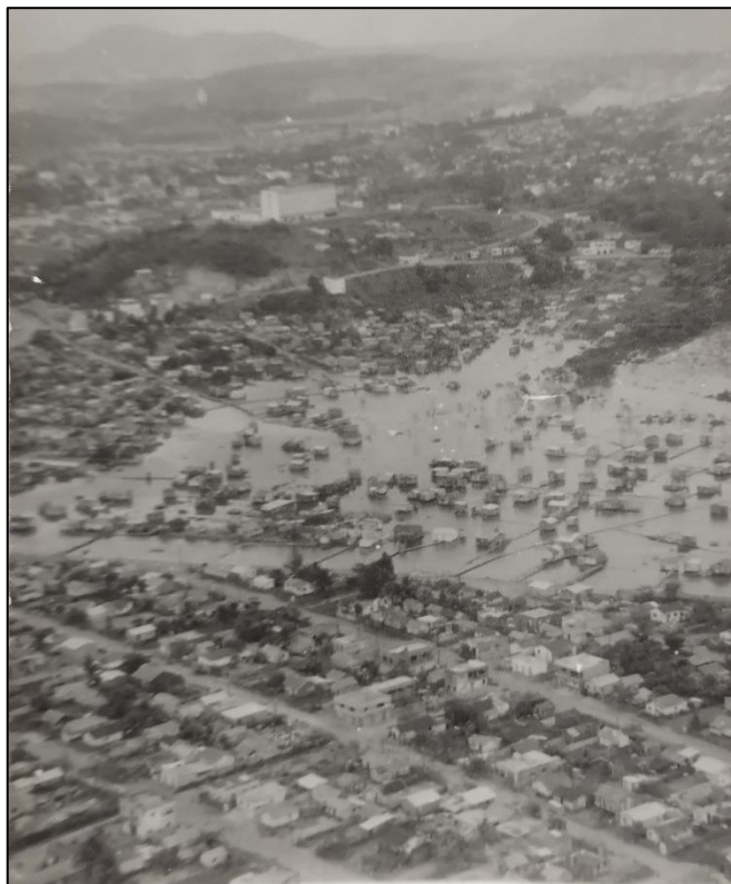
Figura 1 – Vista aérea de Primeiro de Maio completamente alagado em 1978.
