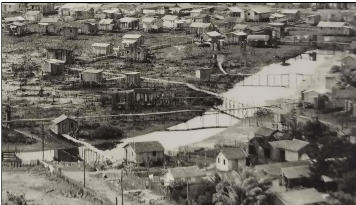
Figura 3 – Destaque para as passarelas improvisadas (as pinguelas) em Primeiro de Maio, conectando as moradias com a saída da Ilha de Santa Rita.
