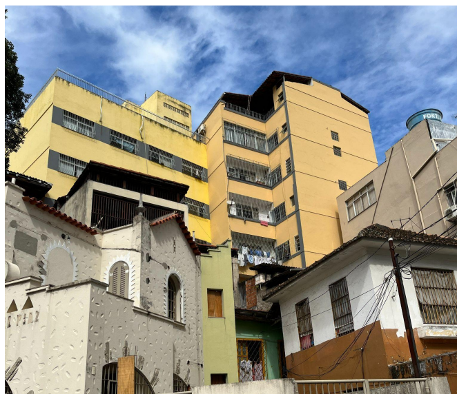
Figura 02: Emaranhado de construções na Rua Caramuru no Centro, Vitória/ES.
